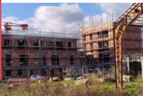
Construction rue de Paris - Montreuil (93)
