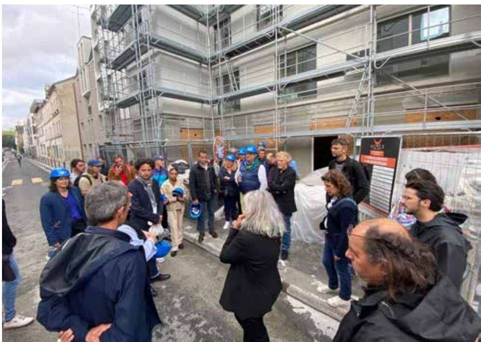
Visite de chantier - rue des Maraichers - Paris (20 ième )
