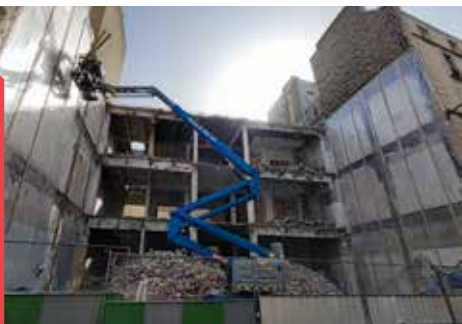
Démolition - rue Pajol - Paris (18 ième )
