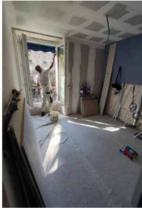
rue Barbès - Paris (18ième) - phase travaux
